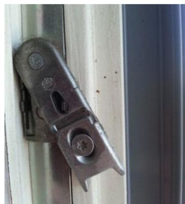
пружиненный элемент, напоминающий пластину или кнопку, который выступает сбоку створки, на стороне ручки (их фото есть выше). Нужно нажать пальцем на него. Если блокиратор имеет вид пластины, торчащей под углом, следует прижать его в сторону уплотнителя.
